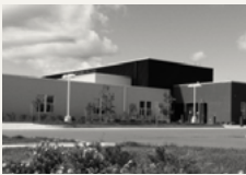
2009 Ouverture du nouveau Centre Sister Margaret Smith. 2010 Début de la préparation du terrain en vue de la construction des nouveaux appartements Sister Leila Greco.
