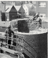
2012 Début de la préparation du terrain en vue de la construction de la nouvelle aile est de l’Hôpital St Joseph.
